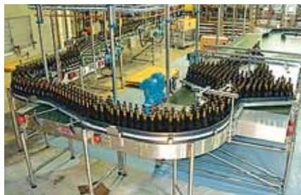
Рис. 2. Линия транспортировки бутылок от наполнительной до укупорочной машины
